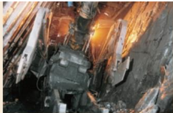
▲ En 1982, 24 machines d'abattage ANF équipent les chantiers en dressants.
